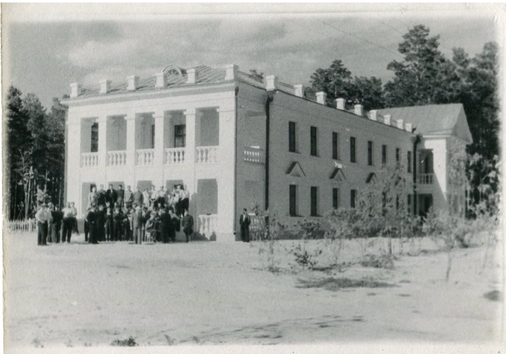
Ил. 2. Строители корпуса Бердского Дома отдыха ВЦСПС. 09.07.1951 г. Из фондов Бердского историко-художественного музея.
