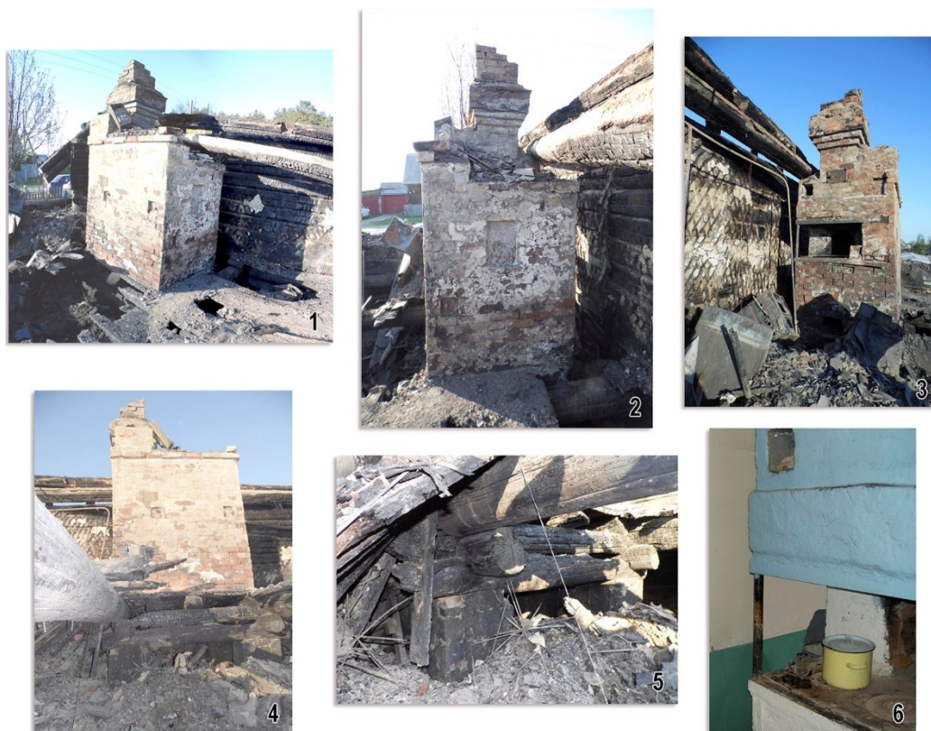
Ил. 3. ПМА. Ул. Дачная, 32. Следы огня внутри дома (1–3 — на уровне пола, у печи; 4–5 — ниже уровня пола, у печи; 6 — для сравнения: состояние печи до пожара).
