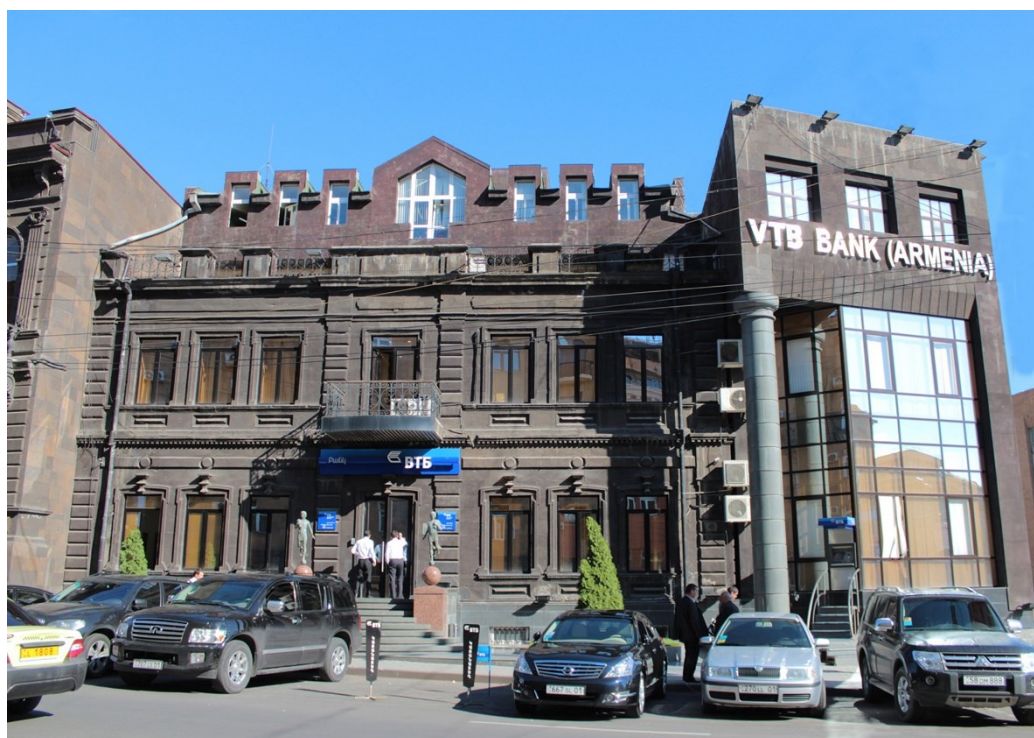
Ил. 4. Адаптация, реконструкция и расширение доходного дома на улице Налбандяна под Армсбербанк, 1996-2002. Фотография автора Fg.4. Adaptation, reconstruction and expansion of the apartment house on Nalbandyan street under Armsberbank, 1996-2002. Photo of the author
