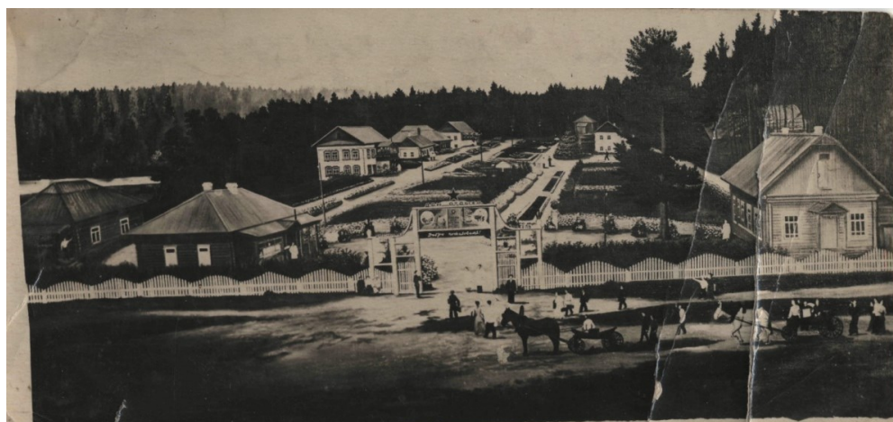
Ил. 1. Бердский Дом отдыха ВЦСПС. Панорамный вид. 1944 г. Из фондов Бердского историко-художественного музея.
