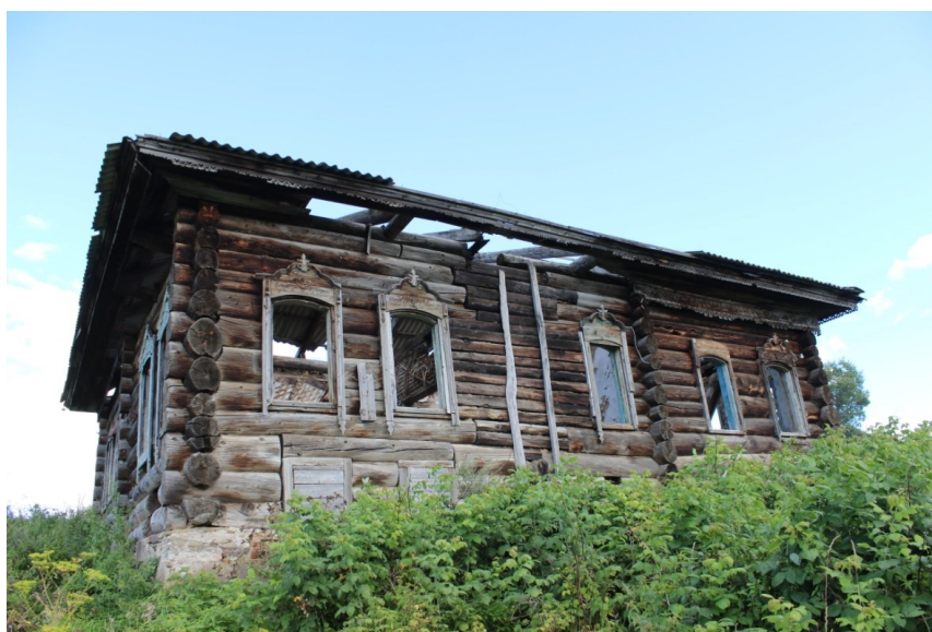
Ил. 1. Жилой дом в с.Зарубино Топкинского района Кемеровской области, ПМА. Fig. 1. Residential building in the village of Zarubino, Topkinsky district, Kemerovo region.
