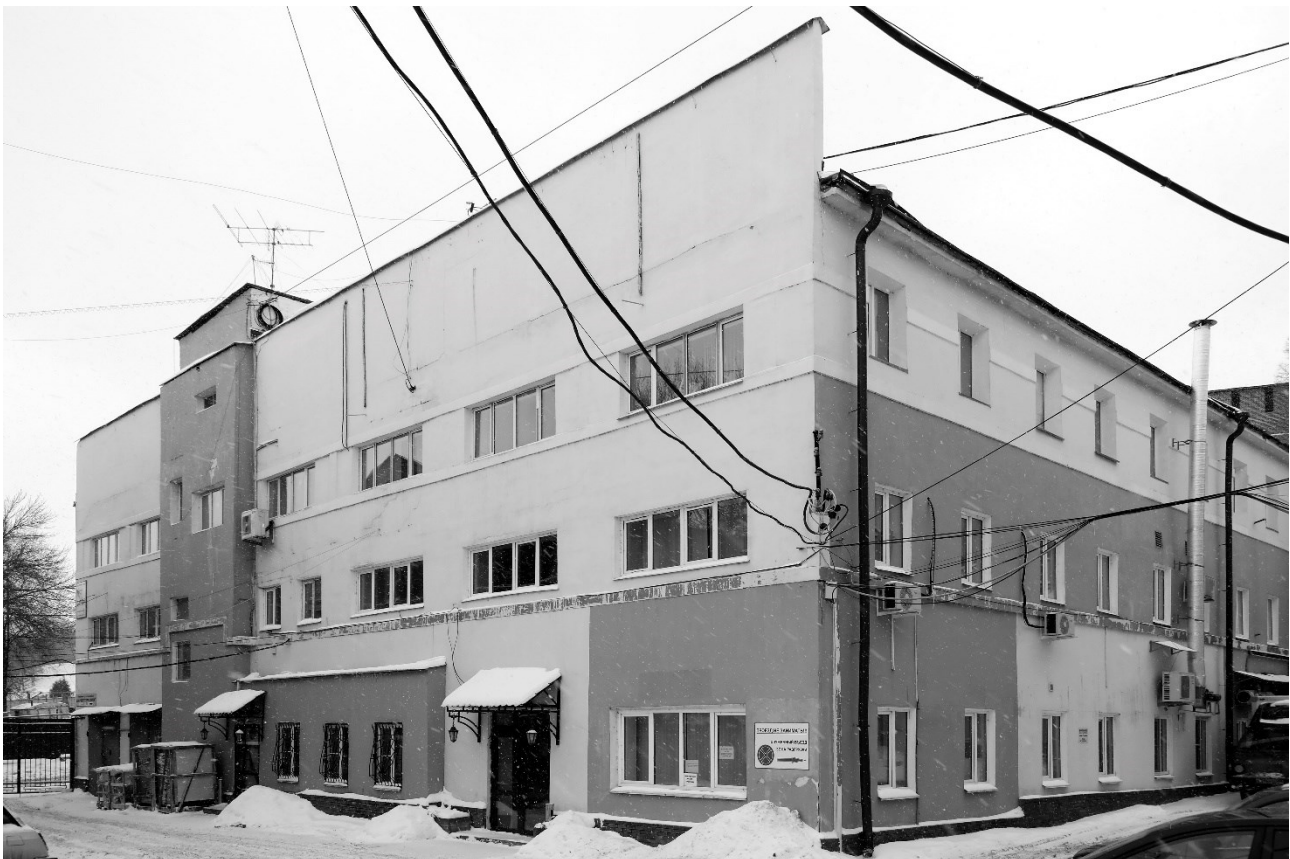
Ил. 7. Холодильник Госрыбсиндиката в Нижнем Новгороде. 1927–1928. Общий вид со стороны Волги. Архитекторы М.Я. Гинзбург, С.М. Муромцев, инженеры С.Л. Прохоров, Н.А. Кашкаров и А.А. Поляков. [Фото автора. 2016].
