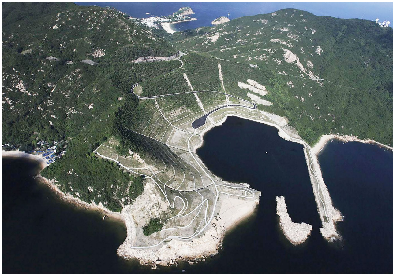
Ил. 1. Реабилитация нарушенной антропогенной территории методом рекультивации, карьер в Гонконге, Urbis Limited (URL: https://www.urbis.com.hk/mobile/en/projects/detail.php?category=3&id=142 )
