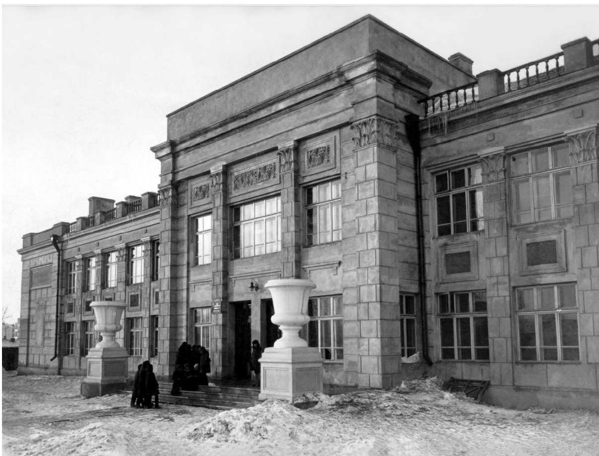
Ил. 3. Школа по ул. Ермака. 1935 г. [Новосибирск в фотозагадках, 2019]
