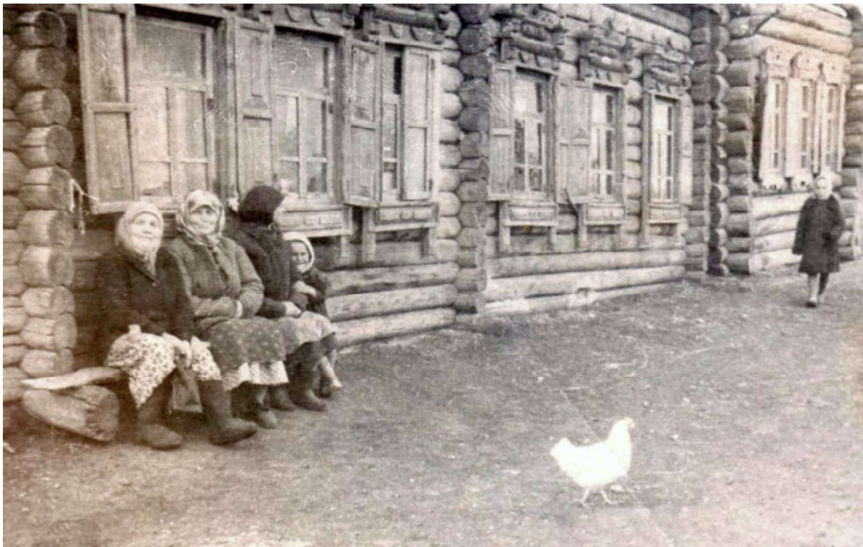
Ил. 3. Рубленый дом в д. Антошкино. Нач. XX в. Из личного архива Г.А. Шихалевой
