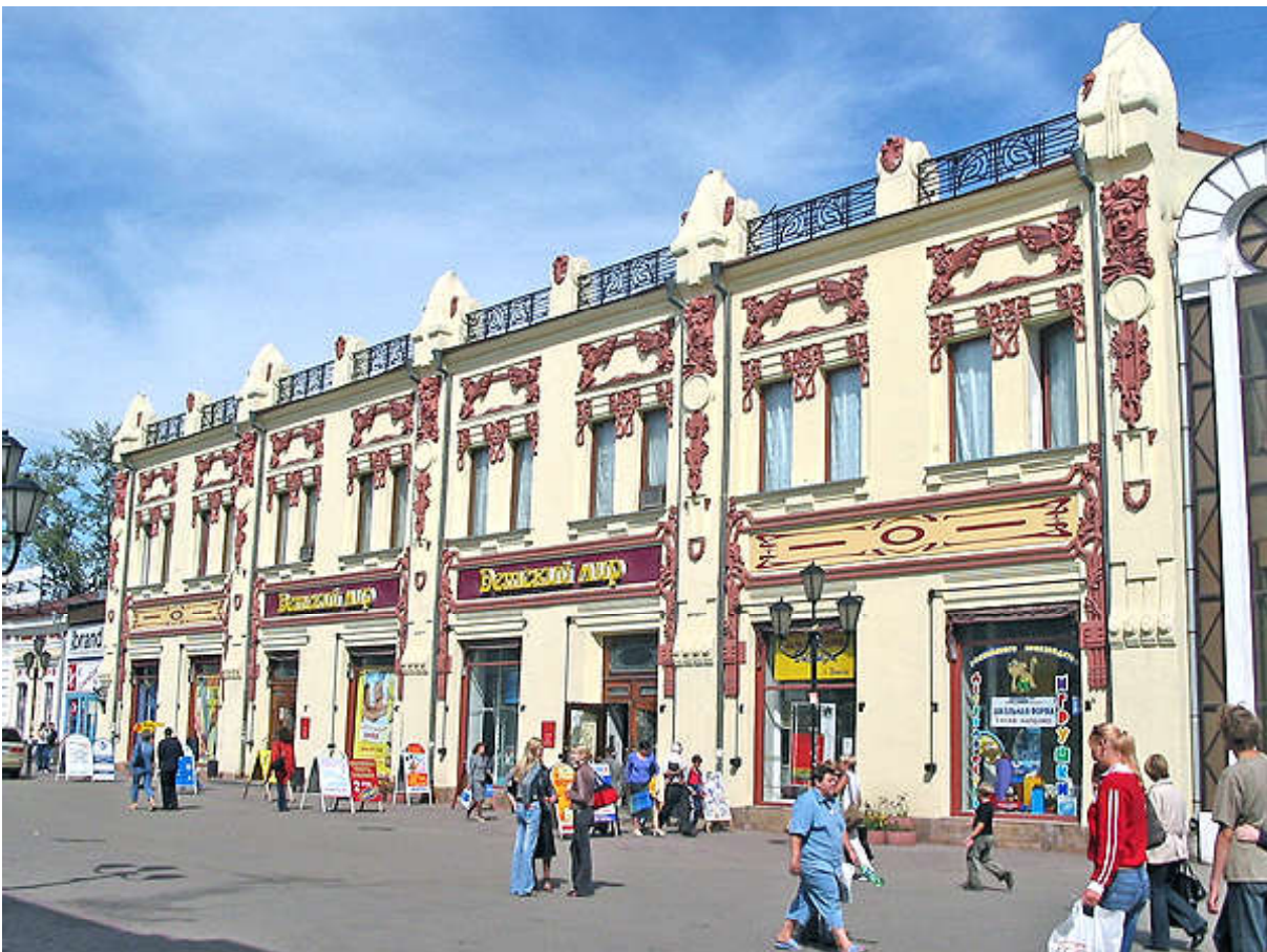
Ил. 2. Здание магазина «Детский мир» в Иркутске (ул. Урицкого, 1), архитектор А.П. Артюшков (URL: https://clck.ru/HMPZA )
