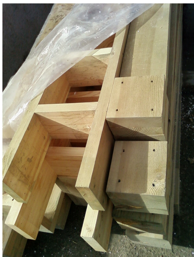
Рис. 8. Конструкция колонн без облицовки плитой OSB
