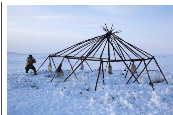
Рис. 7. Сооружение каркаса яранги
