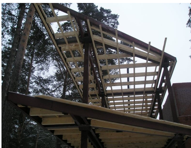
Рис. 6. Рамный каркас пристройки к коттеджу
