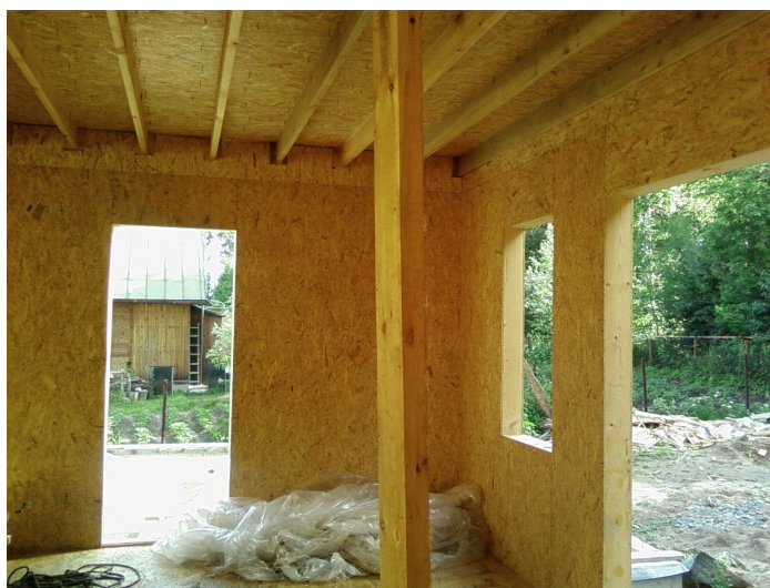
Рис. 9. Подпорка под главной балкой
