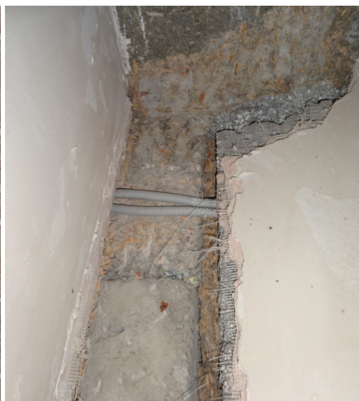
Рис. 4. Фрагмент стены из пенополистиролбетона Рис. 5. Сопряжение колонны и стены
