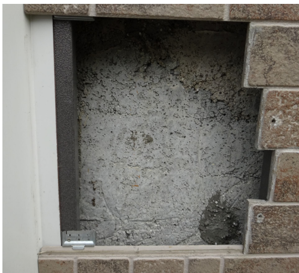
Рис. 4. Фрагмент стены из пенополистиролбетона Рис. 5. Сопряжение колонны и стены
